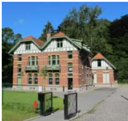
L'ancien captage de la CIBE.
